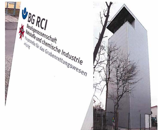
Der schiefe Turm gehört zum Übungsgelände des Grubenrettungswesens.
